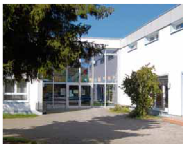
Eine neue Glasfassade hat der Haupteingang der Grundschule Issing im Rahmen der energetischen Sanierung bekommen. Fotos (2): Martin Geier
