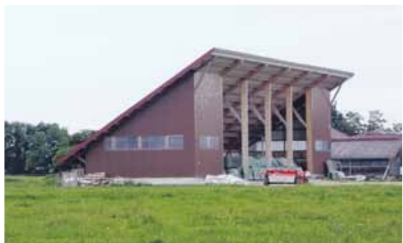
Vom Querschnitt ähnelt die beantragte Lagerhalle diesem Stadel. Sie wird in Massivbauweise, vorne geschlossen ausgeführt. Das Dach reicht noch weiter auf den Boden. Foto: Ulrike Reschke
