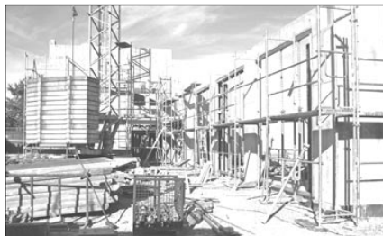
Der Rohbau mit den drei Toren der Fahrzeughalle.
