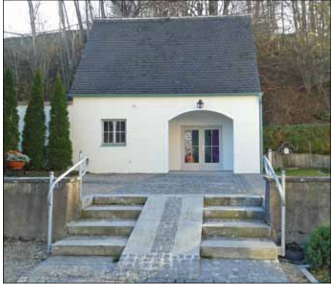
Das runderneuerte Leichenhaus im Issinger Friedhof mit den neu installierten Handläufen an der Zugangstreppe.
