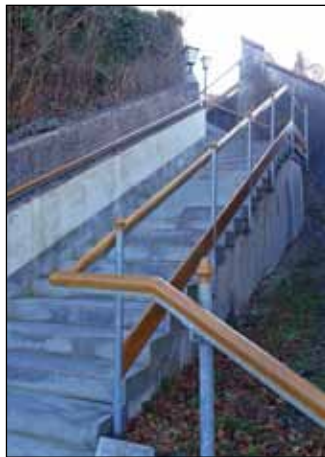
Schön geworden: Der renovierte Handlauf am Aufgang zur Issinger Kirche.
