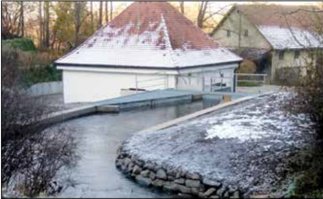
Die sanierten Wasserführungen in Lechmühlen. Rechts ans Pumpenhaus ist der Turbinenschacht angebaut.
