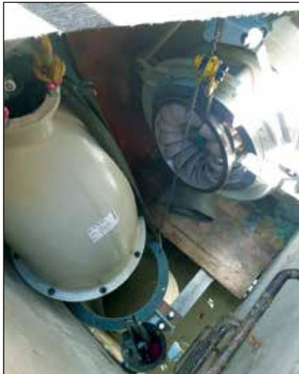
*Der Turbinenschacht am Pumpenhaus Lechmühlen vor der Sanierung der Turbine (links) und beim Einsetzen der runderneuten Turbine und des neuen Saugrohrs. Bilder: Andreas Arnold*
