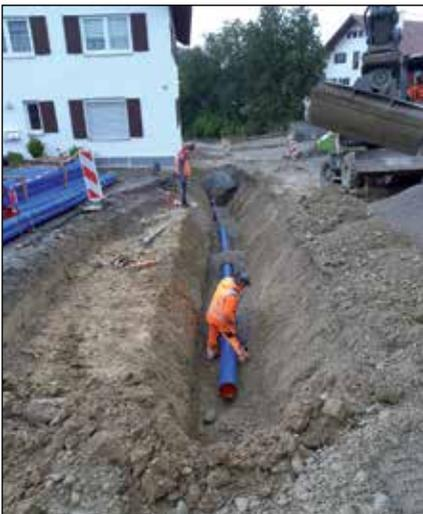
*Im Zuge der Straßensanierung wurde auch ein Abschnitt der Hauptwasserleitung erneuert.*
