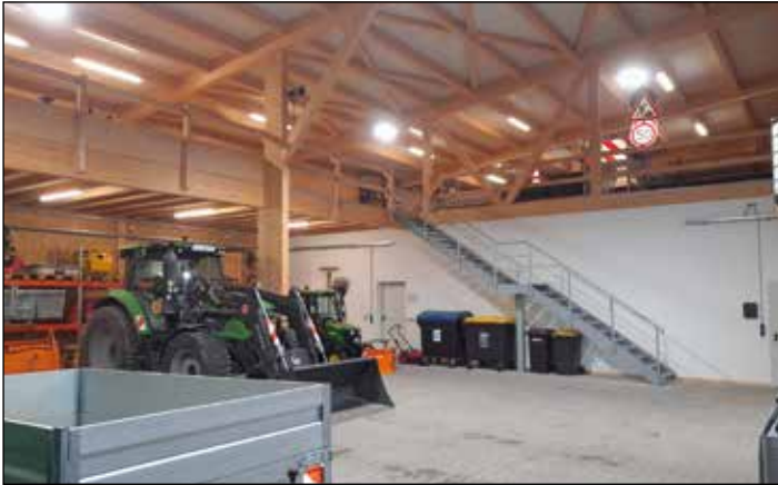
Links der Blick von der Kalthalle hinauf zum Hochlager. Unten eine der beiden beheizten Fahrgassen.
