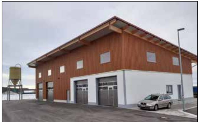
Die neue Bauhofhalle in der Gewerbestraße.
