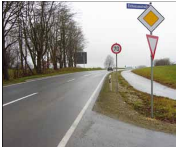
Nur 164 Meter Sichtweite – ein guter Grund für eine Geschwindigkeitsbegrenzung auf der Kreisstraße.
