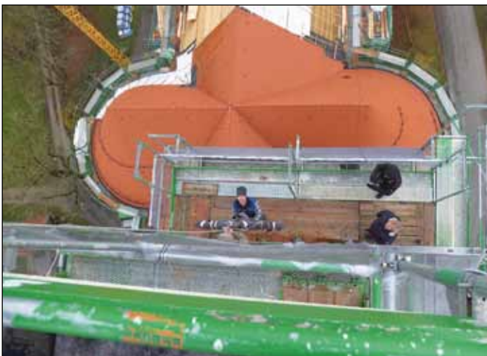
Die letzten Meter musste das Kreuz am Seil bis zur Turmspitze hinaufgezogen werden.
