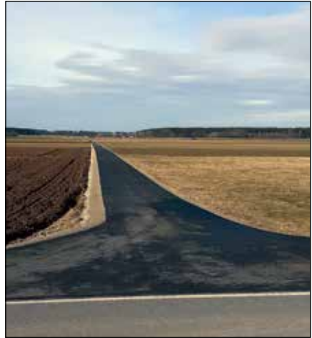
Die neu asphaltierte Radwegstrecke östlich von Pflugdorf. Bild: ath
