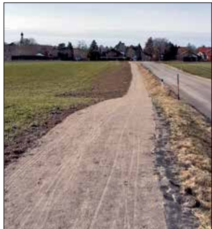
Der neue Gehweg an der Dettenschwanger Straße von Osten. Bild: ath
