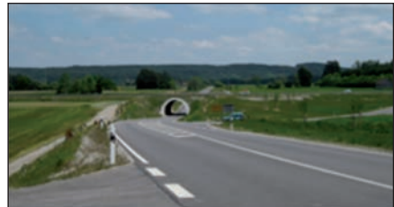
Die 2013 fertig gestellte Unterführung mit Wellstahlrohr bei Dornstetten.
