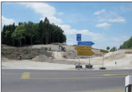
Arbeiten an der Dammaufschüttung für den neuen Verlauf der B17.
