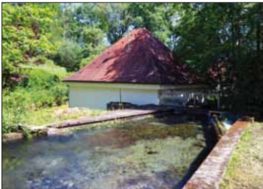
Das Pumpenhaus der gemeindlichen Wasserversorgung in Lechmühlen. Das hier zulaufende Wasser treibt die Pumpen für das gesamte Trinkwassernetz an. Bild: Stefan Berger
