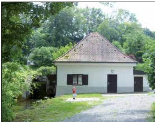
Das gemeindliche Pumpenhaus in Lechmühlen. Links fließt der Mühlbach vorbei, der die Pumpen antreibt.
