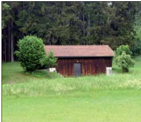
Der Hochbehälter zwischen Issing und Reichling.
