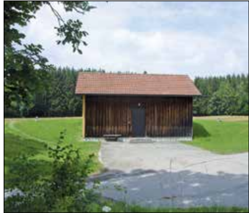
Der Mittelzonenbehälter oberhalb von Mundraching.
