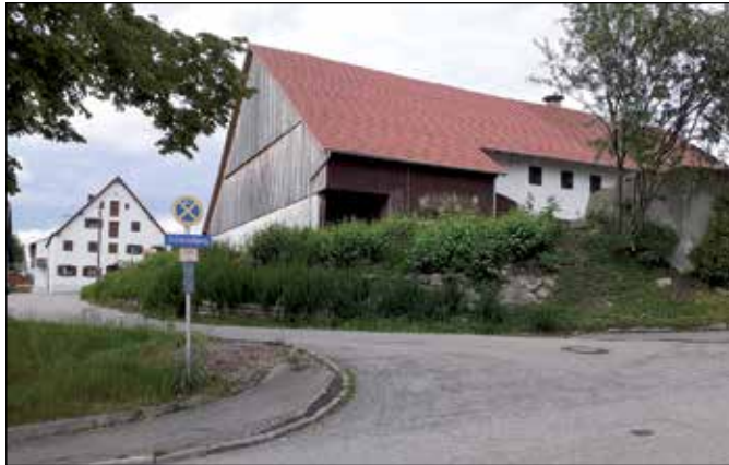
Die Böschung an der Einmündung der Poststraße in den Schmiedberg wird künftig durch eine Natursteinmauer gesichert.
