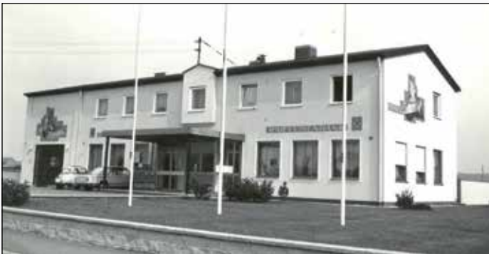
Das 1969 fertiggestellte Rathaus zwischen Pflugdorf und Stadl, mit der Feuerwehrrhalle links und der Raiffeisenbank rechts.
