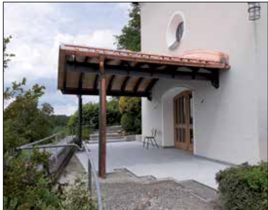
Fast fertig saniert: Das Leichenhaus in Mundraching.
