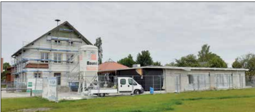
Die Erweiterung des Stadler Kindergartens geht flott voran.
