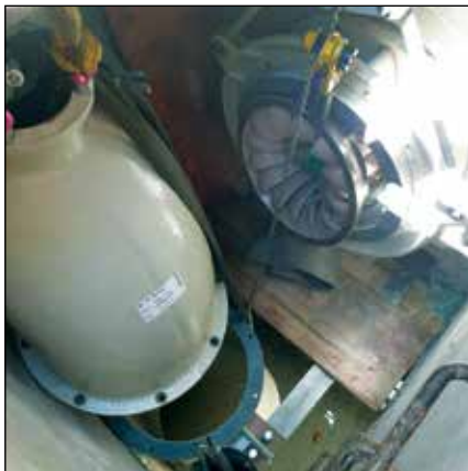
Montage des neuen Saugrohrs und der Turbine im Pumpenhaus Lechmühlen. Bild: A. Arnold
