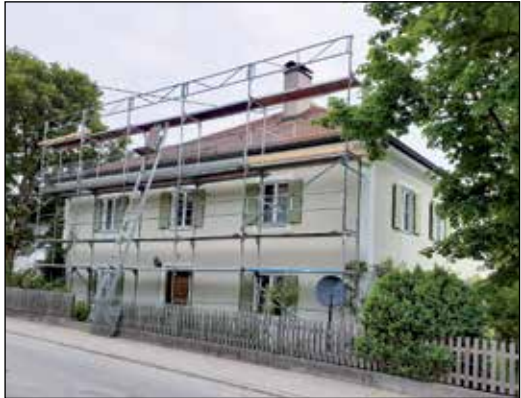
Ebenfalls geschafft ist die Sicherung des Dachstuhls am Alten Pfarrhof in Issing.
