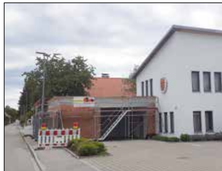
Der Anbau am Feuerwehrgerätehaus Pflugdorf-Stadl hat Gestalt angenommen.
