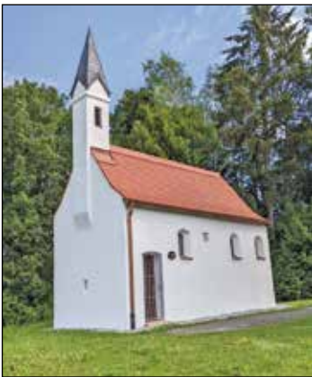
Die sanierte Antoniuskapelle.
