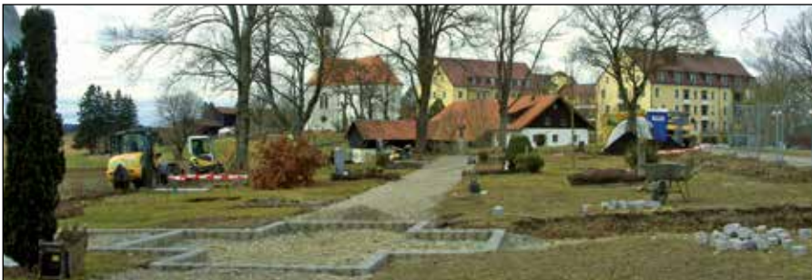
Am Friedhof Vilgertshofen wurde bereits im Februar und März kräftig gearbeitet. Bis April dürfte die Umgestaltung fast schon abgeschlossen sein.
