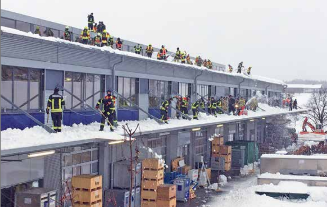
Schneeräumen auf einer Gewerbehalle in Miesbach.
