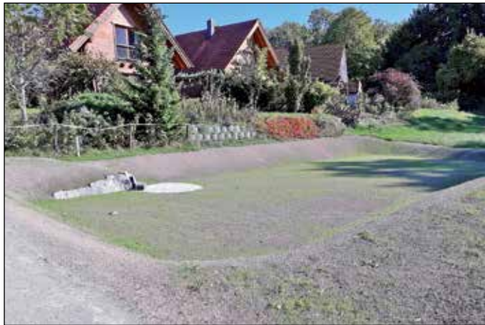
Für die Oberflächenentwässerung am Kapellenweg in Mundraching wurde eine neue Sickermulde notwendig. Bild: Andreas Arnold
