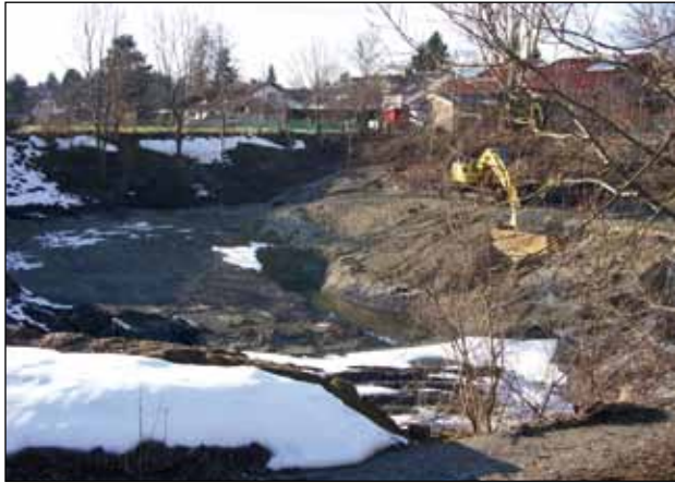
Das Sickerbecken Issing-Ost Anfang März. Endlich geht es voran!
