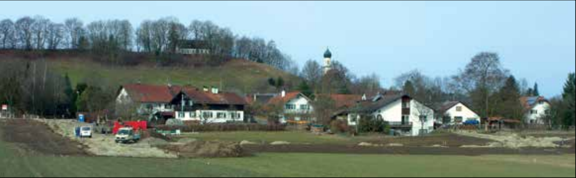
Die Erschließungsarbeiten im Baugebiet „Am Breitele“ in Issing sind bereits weit fortgeschritten.
