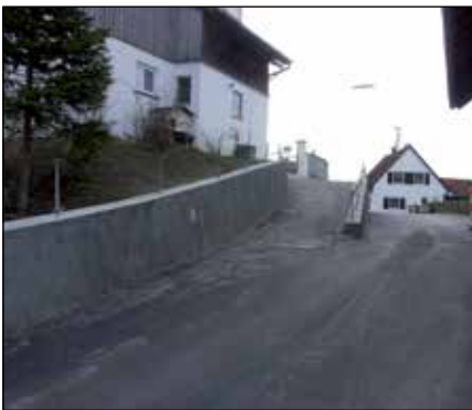
Am Kirchsteig in Pflugdorf wurden die Straße und die Stützmauern saniert.
