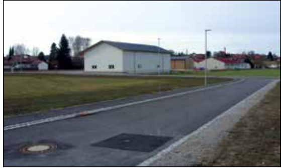
Der zweite Bauabschnitt des Gewerbegebiets Grundacker (hier mit Blick in Richtung Stadt) ist fertig erschlossen. Die ersten Grundstücke sind bereits vergeben.
