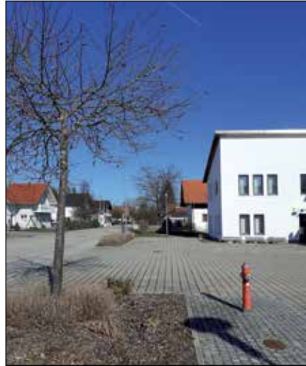
An der Nordseite des Feuerwehrhauses Pflugdorf-Stadl (Bildmitte) wird eine Garage für das neue Kommandofahrzeug angebaut.
