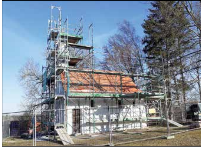
Kunst am Bau: Das Gerüst rund um die Antoniuskapelle in Mundraching.
