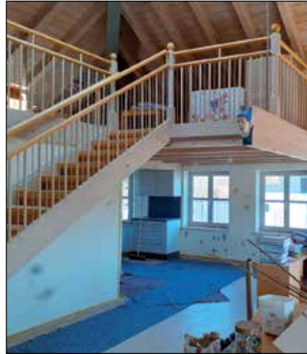
Letzte Sanierungsarbeiten im Pavillon der Kita Stadl.
