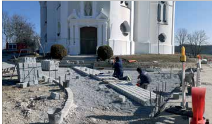
Anfang März wurde der Vorplatz der Wallfahrtskirche gepflastert.
