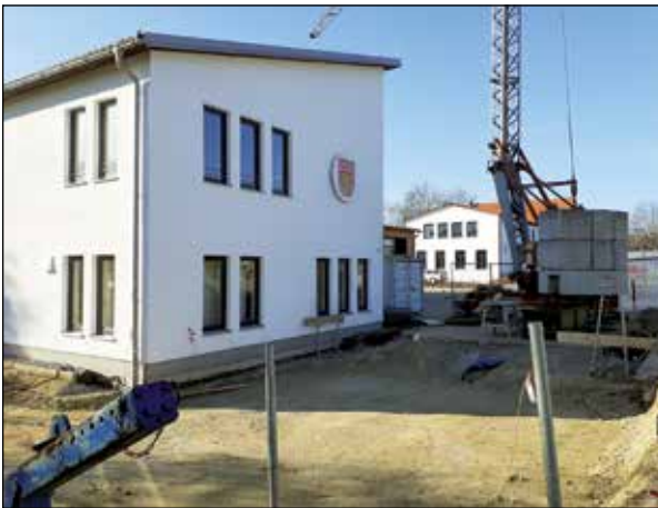
Alles vorbereitet für den Anbau an das Feuerwehrhaus Pflugdorf-Stadl.
