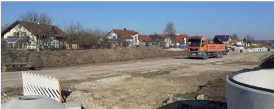
Flott voran geht es im neuen Baugebiet Ahornweg in Pflugdorf.
