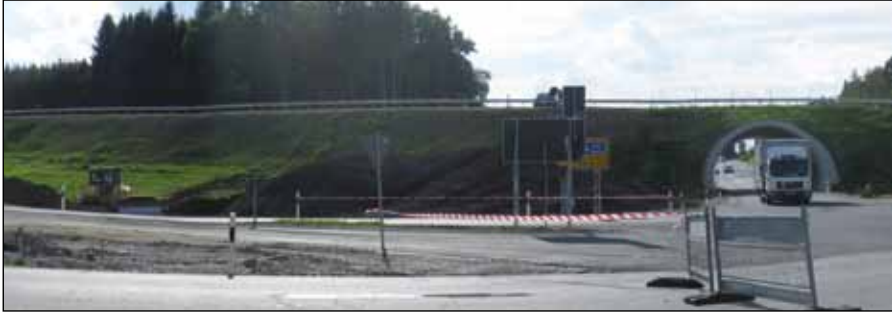
Die neue Unterführung nach Leeder. Links davor die Abfahrt von der neuen B17, ganz vorne die provisorische Umfahrung. Bild: FiVo
