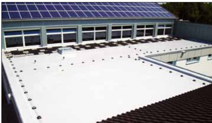
Das runderneuerte Flachdach mit Blick zur Turnhalle.
