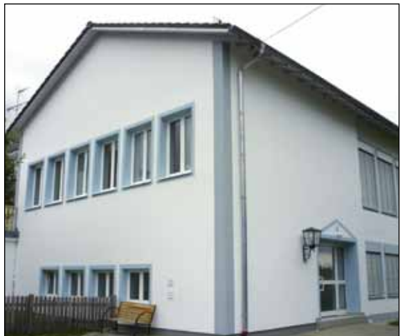
Die Westfassade des Altbaus mit neuer Dämmung und neuen Fenstern. Bild: ath
