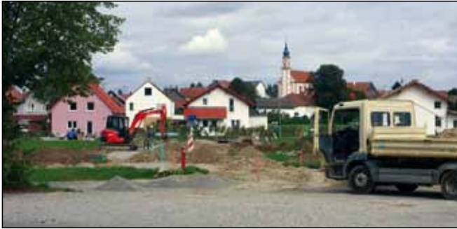
In der St.-Leonhard-Straße wird der 2. Abschnitt des Wohnbaugebiets erschlossen.
