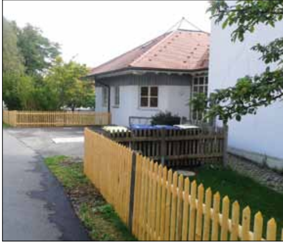
Der Zaun auf der Nordseite des Stadler Kindergartens wurde fast vollständig erneuert. Bild: ath
