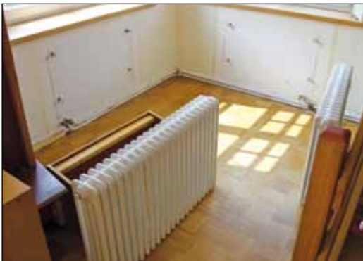
Neue Heizkörper für den Kindergarten Stadl. Bild: Th. Jahl
