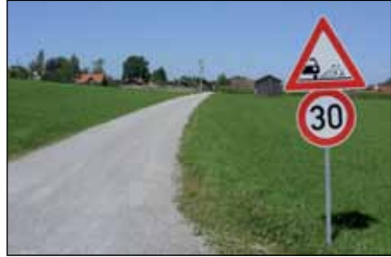
Statt punktuellen Reparaturen erhielt die Eichenseestraße jetzt doch eine flächige Komplettsanierung.
