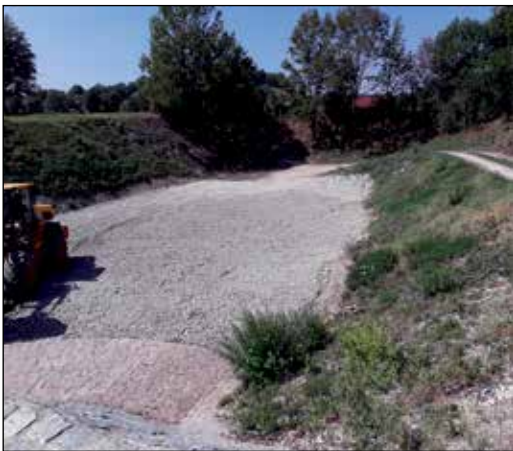
Das Sickerbecken Issing-Ost wurde wieder geräumt. Oben das verdichtete und bewachsene Becken. Das mittlere Bild zeigt die LKW-Flotte, die das kontaminierte Räumgut abtransportierte. Unten das sanierte Becken mit einer neuen Kiesschicht. Bilder: Andreas Arnold
