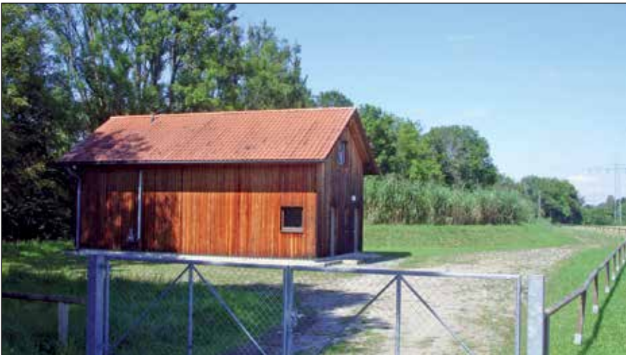
Die Kläranlage für den Ortsteil Mundraching nördlich der Lechbrücke. Im Hintergrund sind die mit Schilf besetzten Vertikalfilter zu erkennen.
