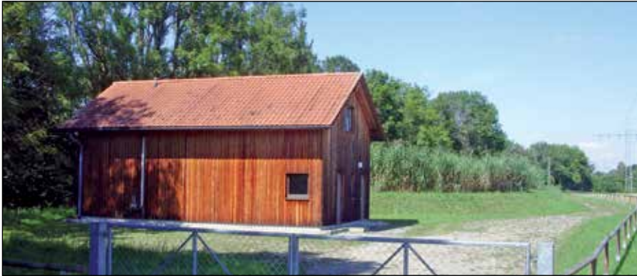
Die Kläranlage für den Ortsteil Mundraching nördlich der Lechbrücke. Im Hintergrund sind die mit Schilf besetzten Vertikalfilter zu erkennen.
