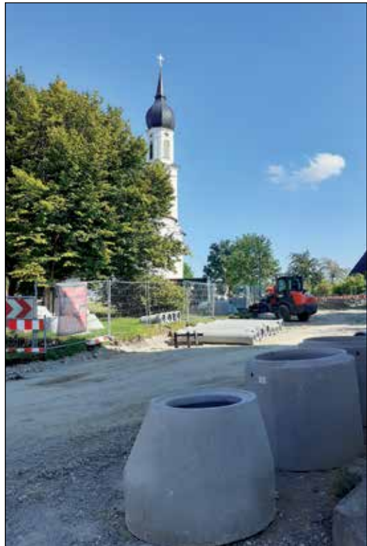
Das unterste zuoberst: Der Vilgertshofer Ortsplatz als Großbaustelle.
