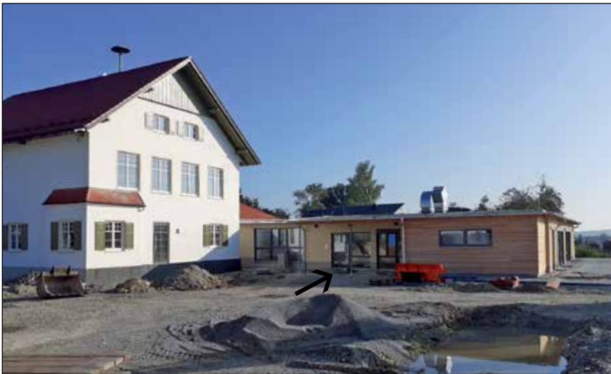
Von den neuen Parkplätzen an der Johann-Baader-Straße geht es künftig direkt zum neuen Haupteingang im Anbau der Stadler Kindergartens (Pfeil).
