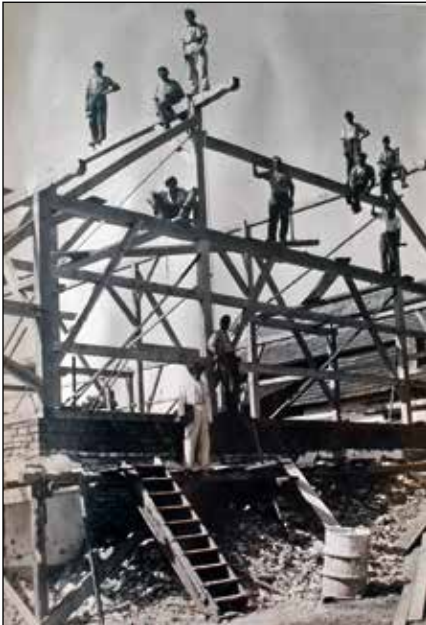
Andreas und Sonja Sturm schickten ein Foto von 1950, auf dem die Handwerker unter den damaligen Arbeitsbedingungen ungesichert und locker auf den Balken stehen.
