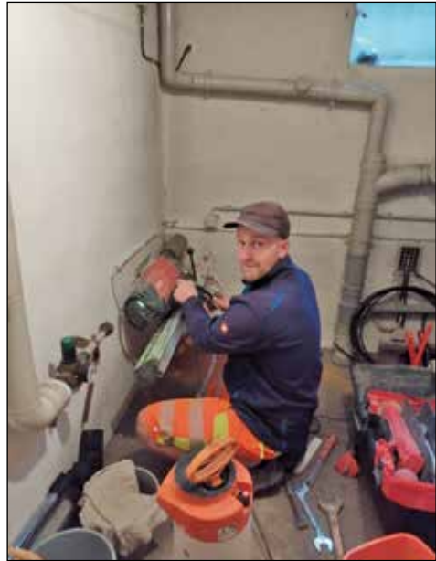
Wassermeister Tobias Knogler arbeitet an einem Trinkwasser-Hausanschluss.
