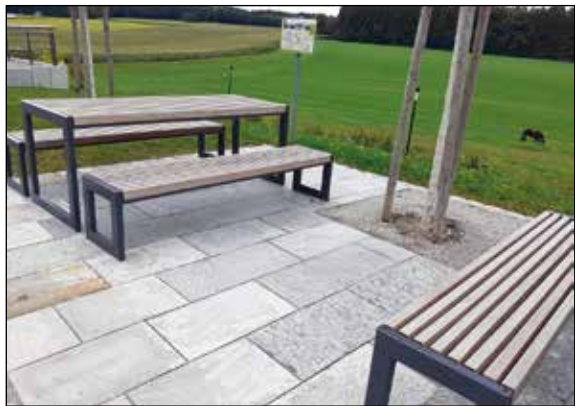
Weil die richtigen Platten (vorne) ausgingen, belegte die ausführende Firma die restliche Fläche an der Vilgertshofer Kirche einfach mit dünneren und andersfarbigen Steinen (hinten). Bild: ath
